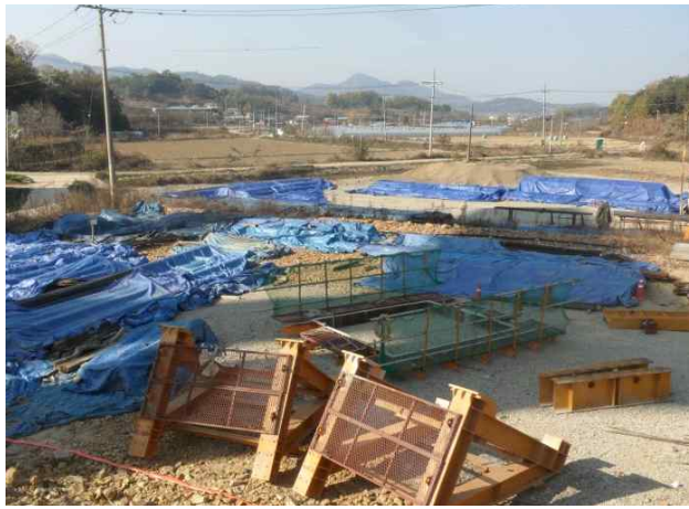
철근 임시 보관 상태
